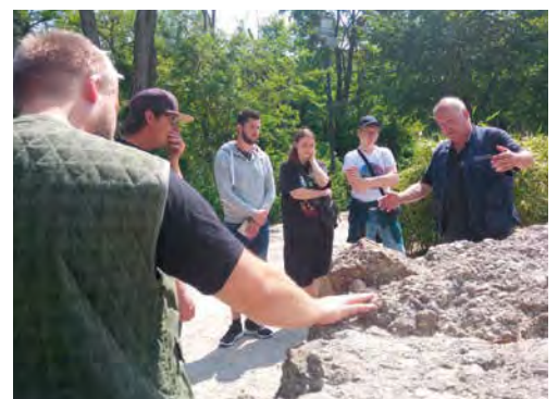
Wir erfahren, wie die Mauer am neuen Elefantenhause aus Beton entstand.
